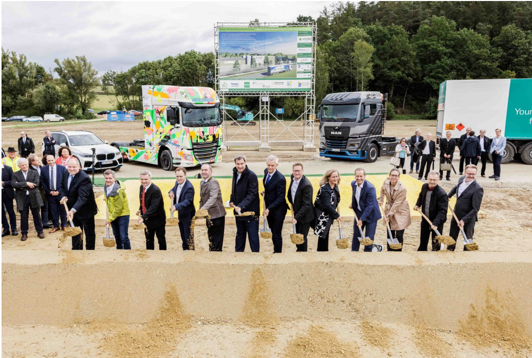
Spatenstich am 15.09.2022 mit Ministerpräsident Dr. Markus Söder (6. v. l.) und Staatsminister für Wirtschaft, Landesentwicklung und Energie, Hubert Aiwanger (5. v. l.). (Bild: Hy2B Wasserstoff GmbH)
