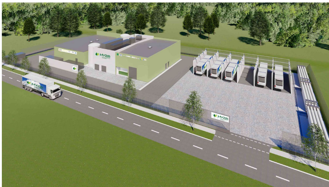
Modell der Wasserstoffherstellungs- und -abfüllanlage Pfeffenhausen mit sechs Abfüllstationen für Druckgas-Trailer. (Bild: Hy2B Wasserstoff GmbH)
