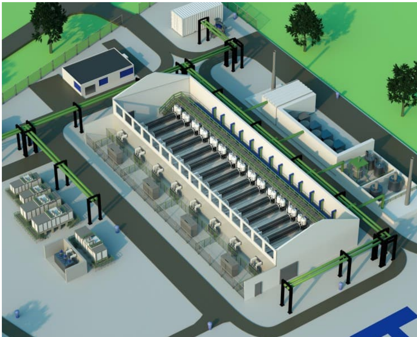
Die zukünftige H 2 eron-Fabrik für grünen Wasserstoff in Delfzijl (Bild: HyCC)
